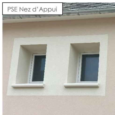
**PSE Appui MSEA** est une gamme d'appuis de fenêtre légers spécialement adaptés en façades.
